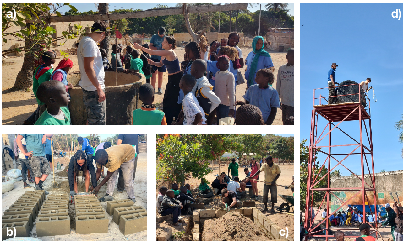
Quelques photos des activités à l'école de Kafountine 2 : a) puisage pour creusage des tranchées. b) fabrication des briques pour le support à robinets. c) construction du support. d) remontée de la cuve et nettoyage
