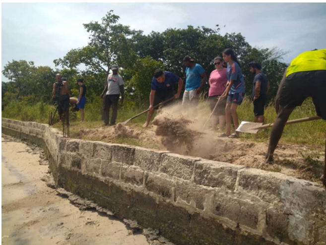
Renforcement de la digue à l'île d'Effrane.
