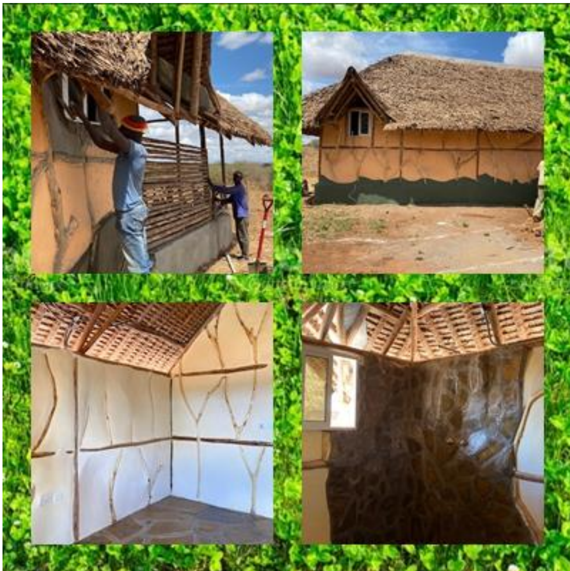
Construction des maisons Lodge de Patrick , cela va être magnifique de loger dans ces petites Lodges au milieu de la nature .
