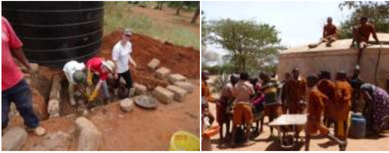
Construction d'un tank, fondation en ciment, pour collecter de l'eau potable dans l'école.
